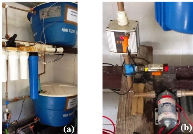
Fig. 3. (a) Planta fotovoltaica para bombeo de agua; (b) - Conjunto motor-bomba y sensores de presión y flujo instalados en las tuberías.
