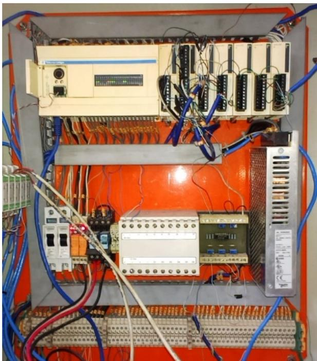
Fig. 17. Hardware del sistema de supervisión para monitorizar y almacenar datos sobre la planta fotovoltaica.
