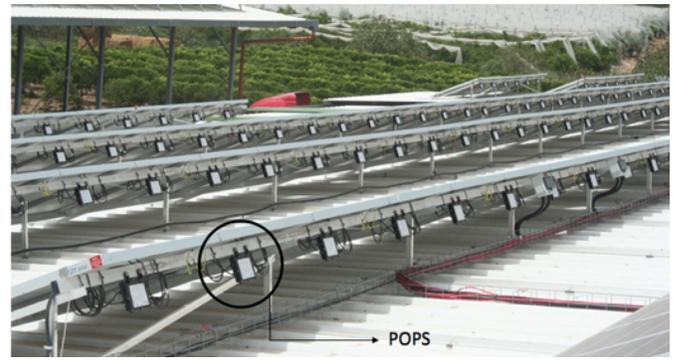
Fig. 1. Sistema FV em Israel com otimizador (POPS) SolarEdge. Fonte: [31].
