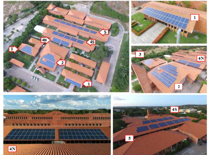
Fig. 1. Disposição dos módulos fotovoltaicos sobre o telhado do campus Floriano do IFPI.
